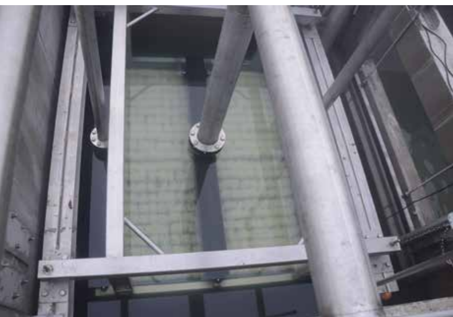
PARTICOLARE DEL MODULO MBR
